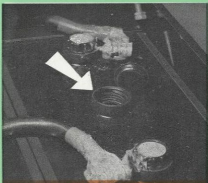
Contrôle du niveau de l'électrolyte dans les batteries 17
